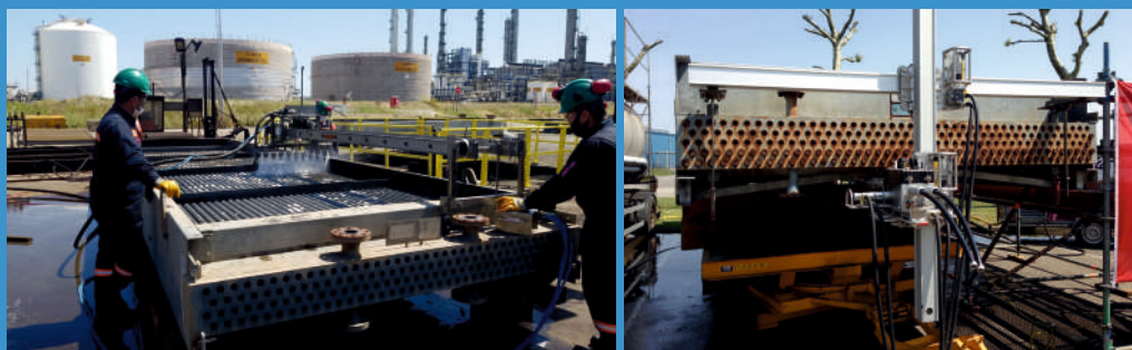
Curățarea interioară și exterioară a fasciculelor tubulare.
